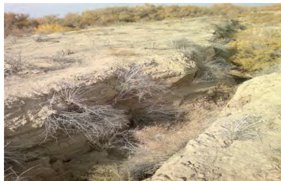
شکل ۲- گسیختگی مشاهده شده در منطقه مورد مطالعه
